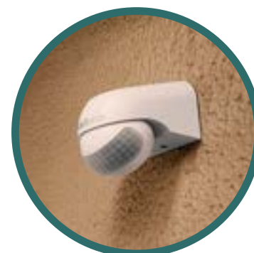
Sensores de presença nas áreas comuns para acionamento das luminárias.
